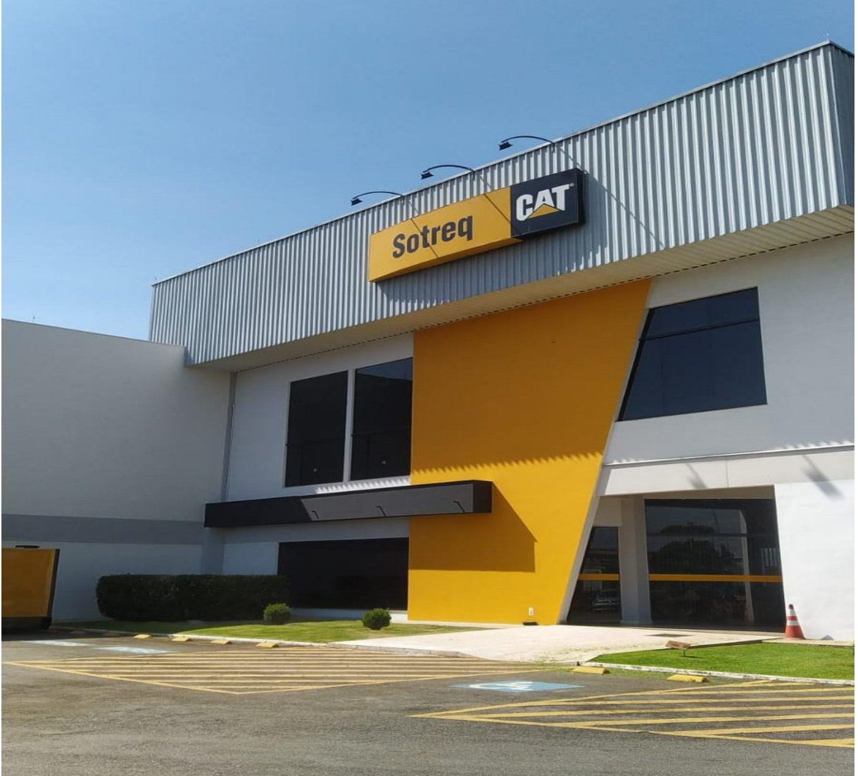
Imagem 1- Centro de Distribuição de Aparecida de Goiânia
